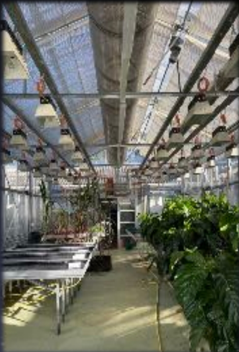
40 LAMPEN HPS VON 600W
